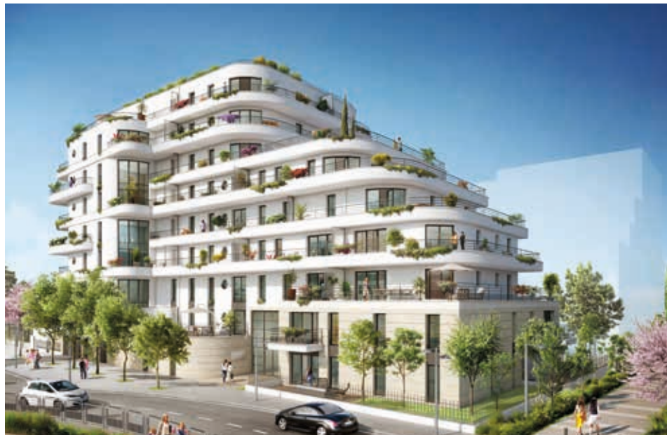
► Les grands ensembles collectifs du programme « Nouvel Horizon » privilégient des gradins-terrasses végétalisées et des façades aérées aux angles arrondis. (Architectes DGM et Associés)
