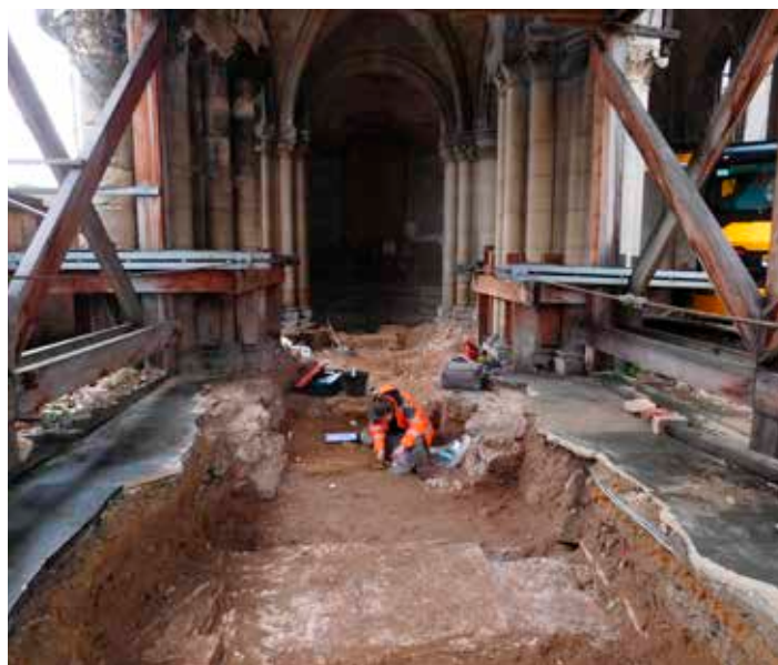
► La fouille de l'ancien clocher Saint-Pierre Saint-Paul, au croisement de la rue du Bournard et de la rue de Verdun, a commencé.
