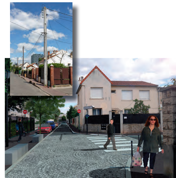
► Alors que les travaux de requalification de la rue Colbert se poursuivent, la rue Jeanne-Gleuzer va être au centre d'un chantier d'enfouissement de ses réseaux aériens (photo de gauche) et d'une requalification complète de la voirie, dans la lignée des travaux rue des Côtes d'Auty (à droite).
