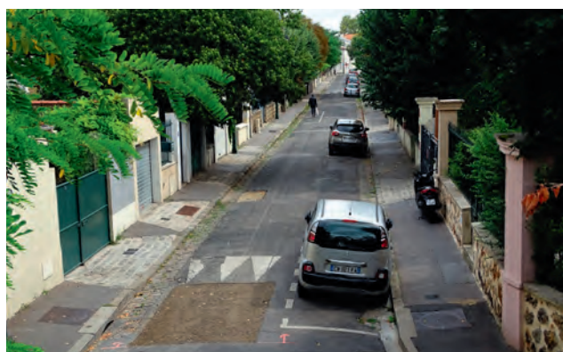
► Les travaux de voirie débuteront en septembre rues des Lilas et Marquet.
