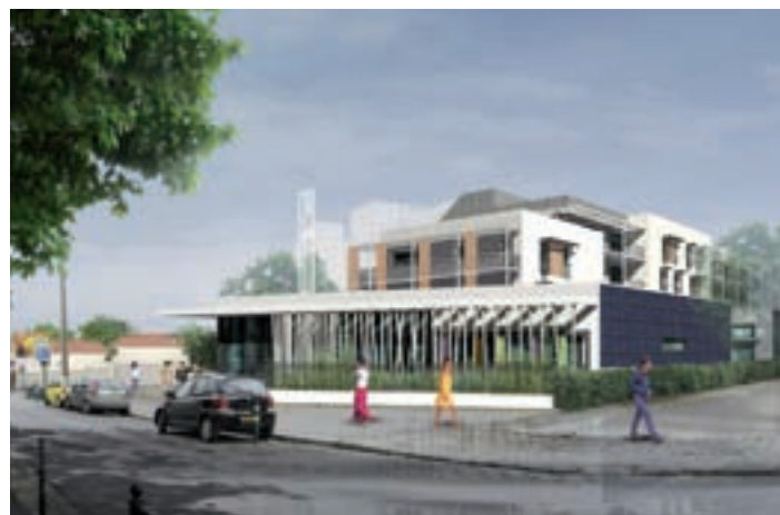
► Situés à l'angle des rues Jules-Ferry et Colbert, les futurs locaux du CSC Petit Colombes seront complétés par 24 logements sociaux.
