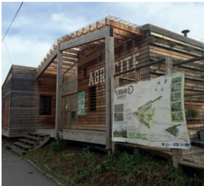
► Après décision de justice, l'Agrocité doit libérer d'ici le mois de mars le terrain communal de la rue Michelet, dont l'aménagement en parking a déjà commencé sur la première parcelle.
