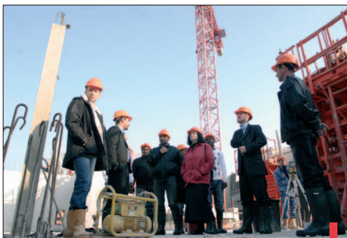
Visite du chantier Lagravère-Mancel.
