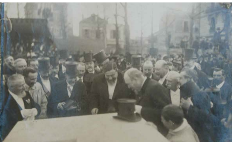
Pose de la première pierre le 2 mars 1913, en présence du préfet de la Seine, Marcel François Delanney aux côtés du maire, Pierre Geofroix (avec le coffret sur la photo). - Photographie, 1913 - Archives communales de Colombes
