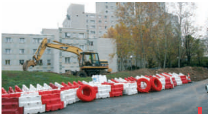
Les travaux de prolongement de la rue Jules-Ferry ont débuté.
