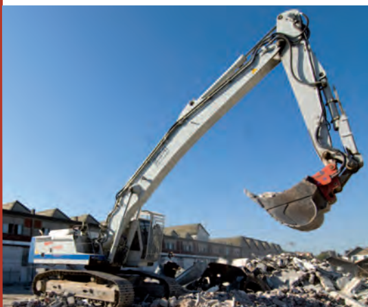
La ZAC de la Marine en septembre pendant les travaux de démolition.
