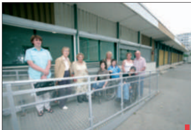
Une nouvelle rampe d'accès au gymnase des Fossés-Jean.
