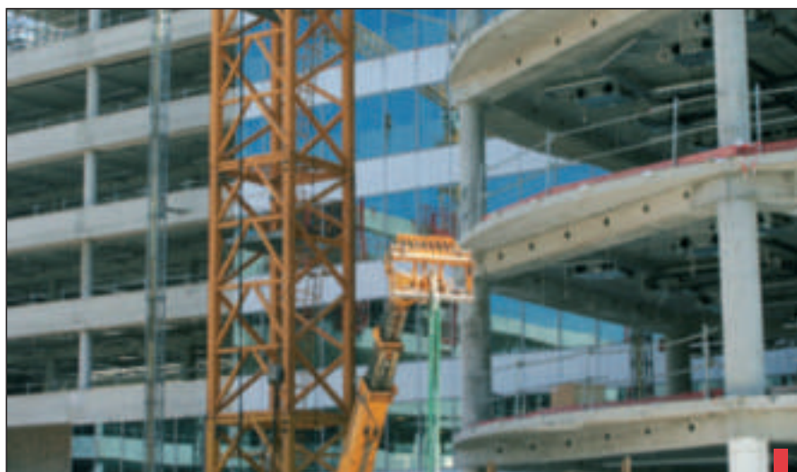
Le chantier Défense-Ouest accueille à ce jour trois bénéficiaires du dispositif « Plate-forme emploi ».
