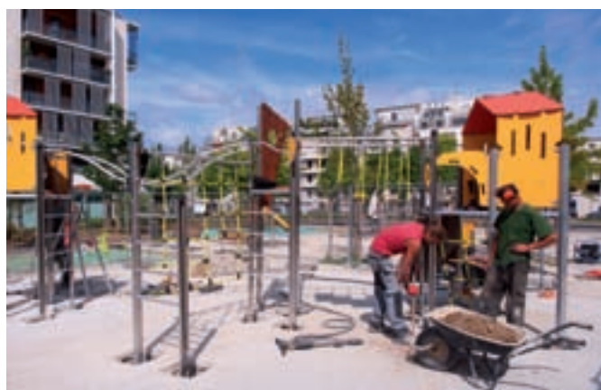
► La nouvelle structure de jeux en cours d'installation à l'heure où nous mettons sous presse peut accueillir jusqu'à 28 enfants en même temps. Photo Philippe Stimaridis
