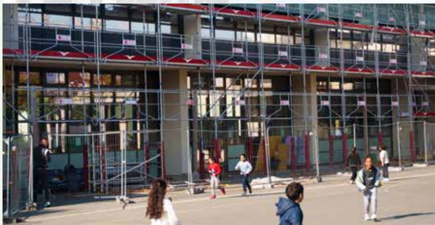
L'école Marcelin-Berthelot en cours de rénovation thermique.
