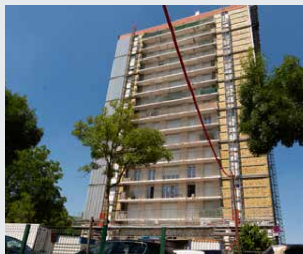
Opération de réhabilitation des tours Audra.
